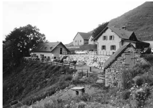
写真1 険しい山腹に立つ作業小屋など
