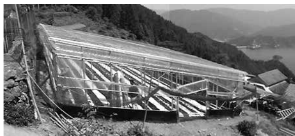
写真2 傾斜畑に設置された建設足場資材利用園芸ハウス
