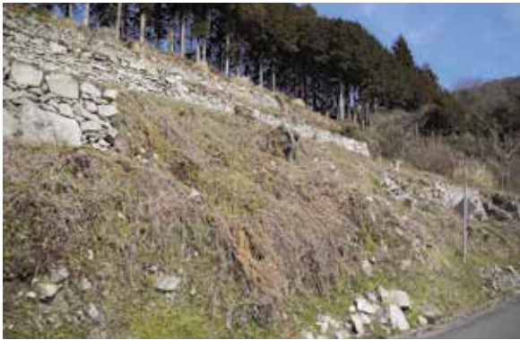
写真1 崩れたまま放置された石積み
