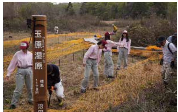
写真2 防獣ネットの設置
