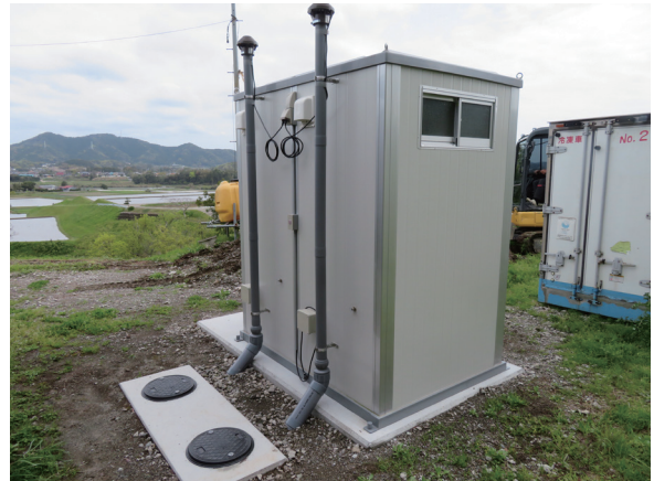
新たに設置されたトイレ
