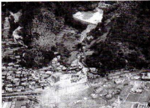
写真-4 ため池堤体外法面の崩壊
