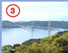
鷹島肥前大橋
