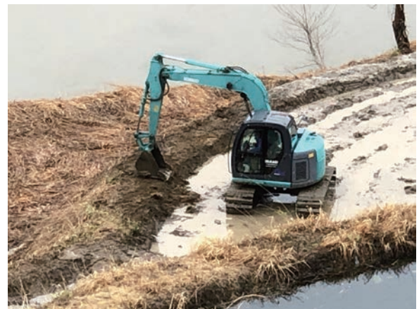
写真3 バックホーのポケットで畦塗り
