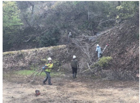
写真1 法面の雑木を切る
