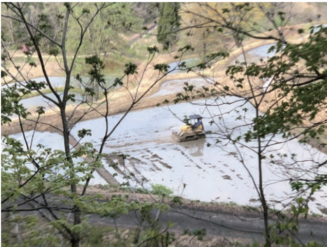
ブルドーザーのブレードを一定の高さに保ってバックしながら均平化(「蒲生の棚田」復田の作業)
